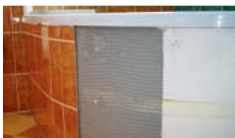
Obložení polystyrenového nosiče
